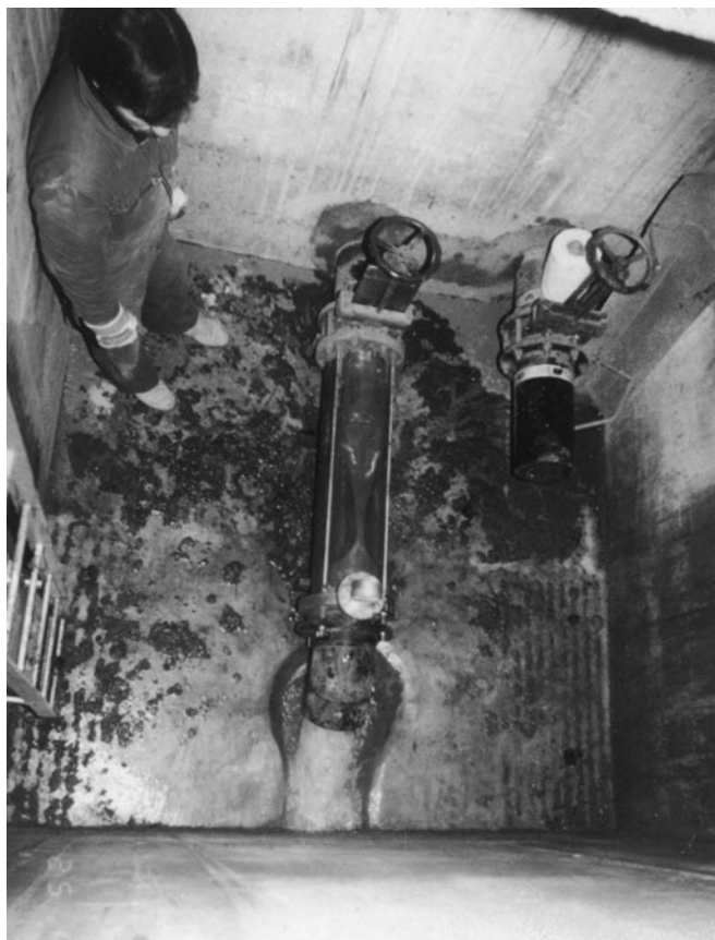
Fig. 5 : Régulateur à membrane UFT- FluidHose type U, DN 200 en implantation sèche. A droite, le bypass.
